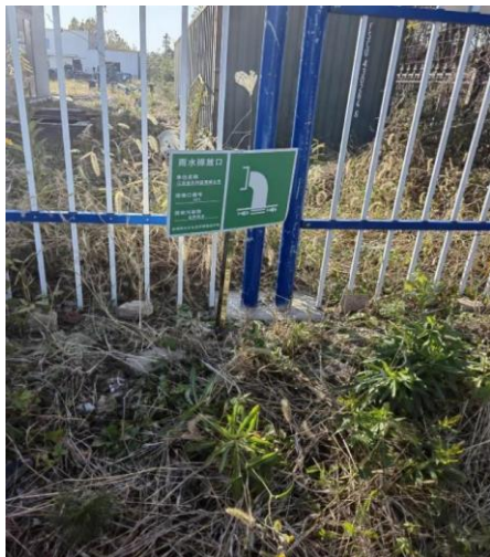
图3-1厂区内雨水排放口
