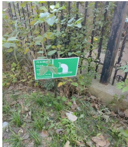
图3-2厂区内污水排放口
